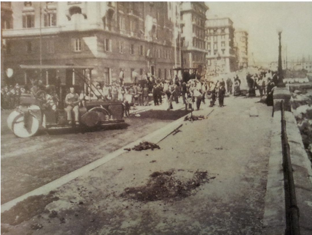
1938- Via Nazario Sauro in corso di rifacimento
