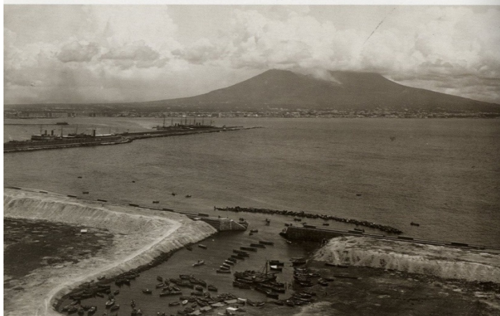
La colmata del rione S. Lucia in costruzione
