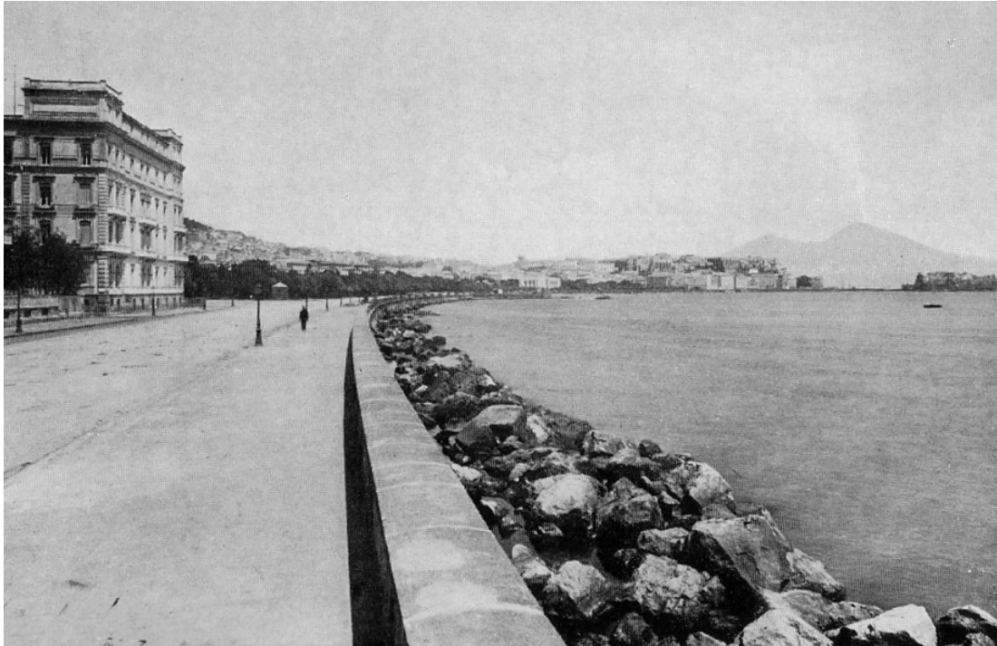
1883 – 1895 via Caracciolo. In corrispondenza del Grand Hotel il parapetto risulta continuo
