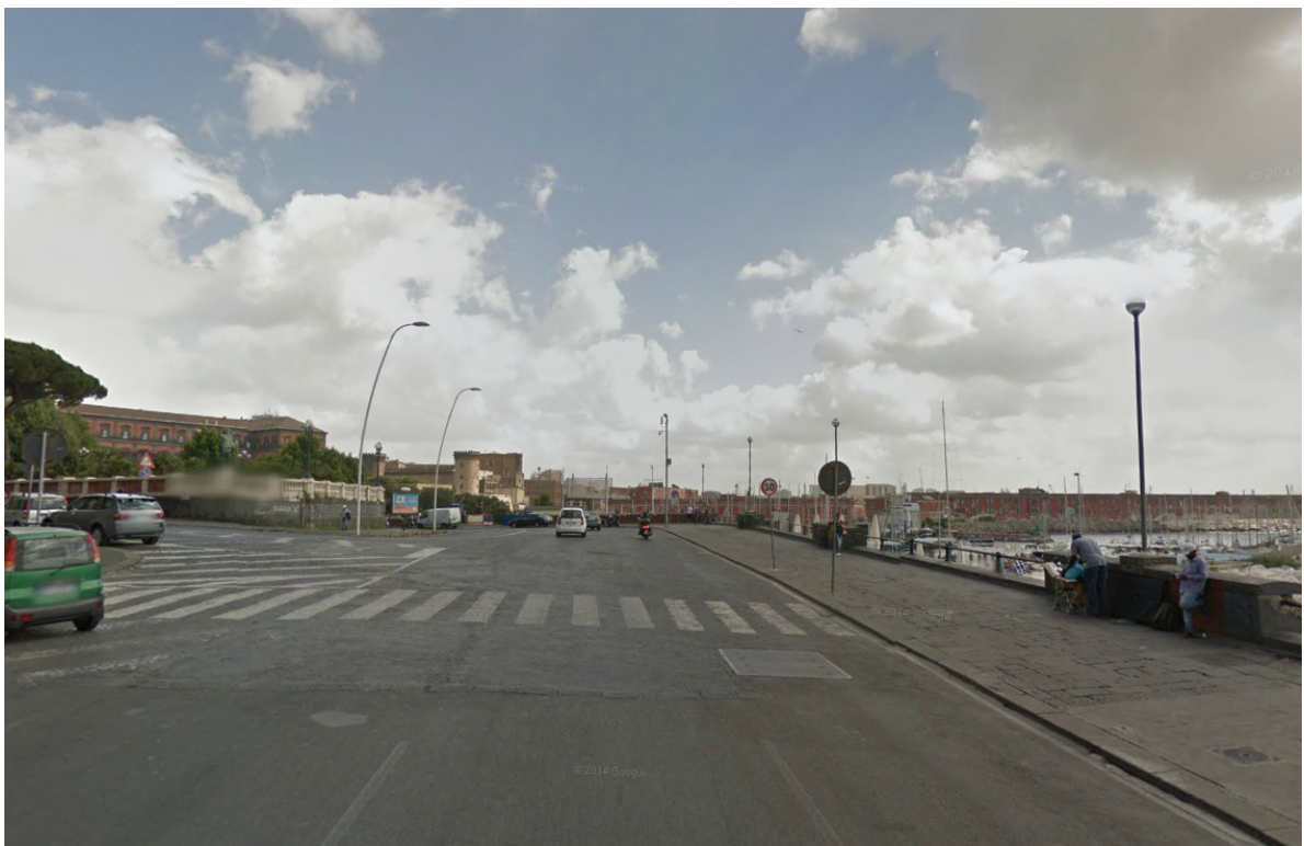
Via Nazario Sauro- Situazione attuale- punto di contatto tra le diverse pavimentazioni (sanpietrini e asfalto)
