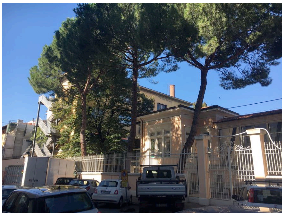
foto 02 vista da via Buonvicini
