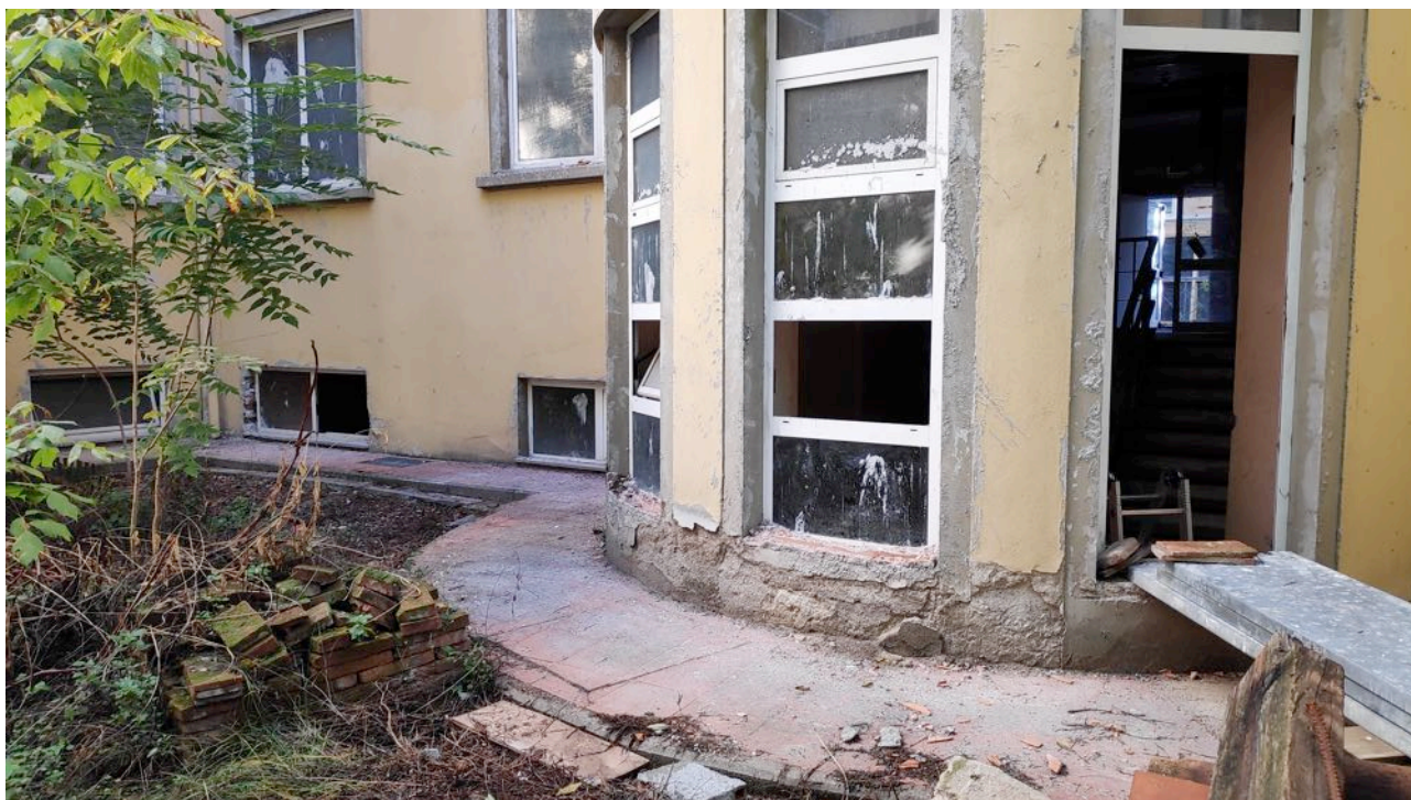
foto 05 – vista tergale del vano scale
