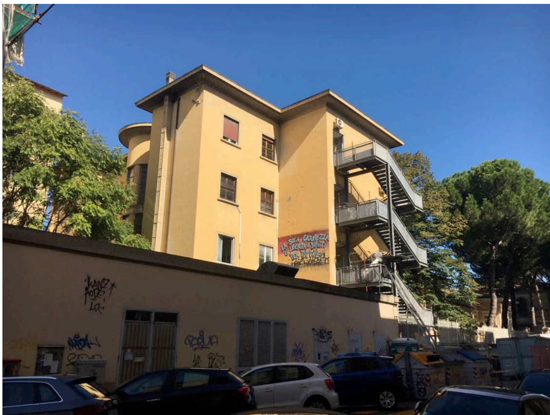
foto 01 vista da via Buonvicini
