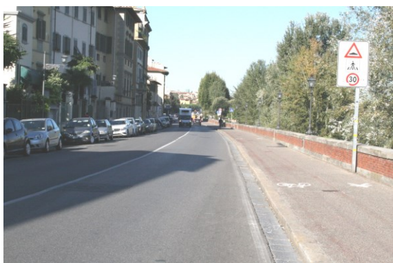
Foto 1 – vista tratto iniziale lungarno Ciellini dir ovest (posti auto da eliminare in sx e ricollocare in dx)
