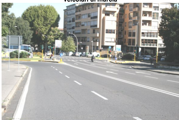
Foto 3 – vista area intersezione nord Risagomatura e riqualificazione delle aiuole spartitraffico Ciclabili contigue su marciapiedi esistenti con risagomatura curvatura marciapiedi
