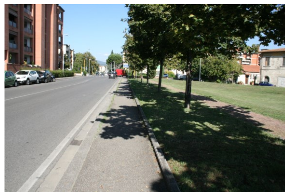
Foto 8 – demolizione del marciapiede per far posto agli stalli di sosta con creazione di salvagente ed interconnessione al pedonale esistente
