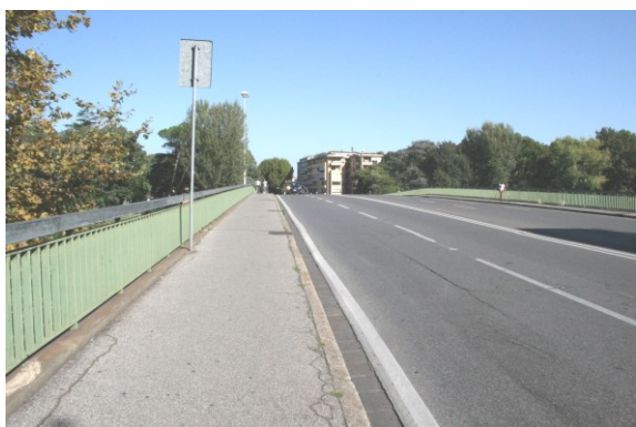
Foto 1 – Ciclabile monodirezionale separata in carreggiata nel tratto dell'impalcato - Attualmente marciapiedi su ambo i lati e n. 5 corsie veicolari di marcia
