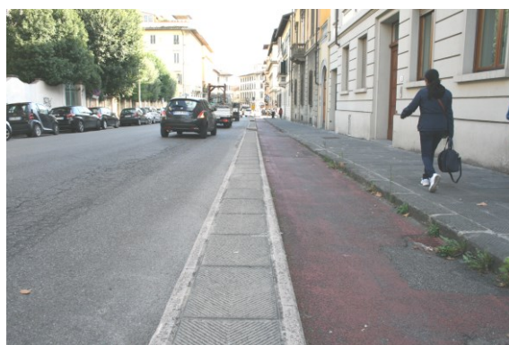
Foto 4 particolare isola di separazione esistente
