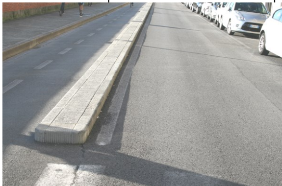
Dettaglio 1 – isola di separazione realizzata su Lungarno Corsini
