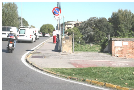
Foto 6 – vista Lungarno Ferrucci Risagomatura del tratto terminale del marciapiede per realizzazione di corsia monodirezionale contigua in quota
