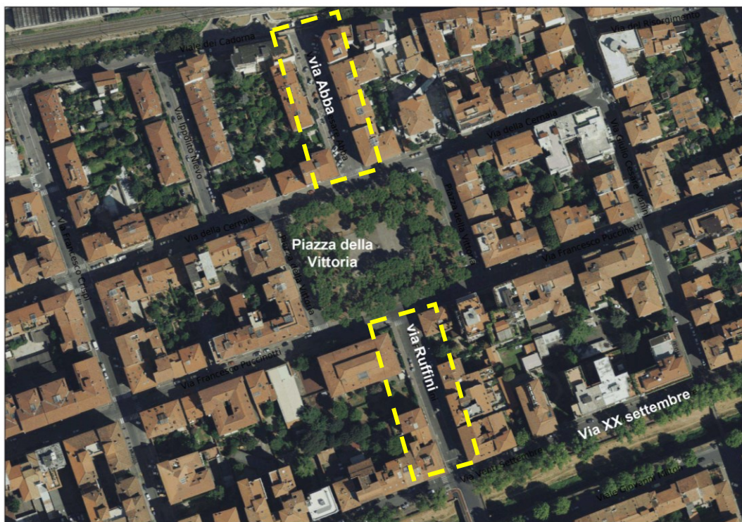
Fig. 1 vista aerea dell'intervento
