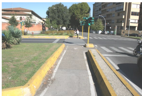
Foto 4 – vista area intersezione nord Risagomatura e riqualificazione delle aiuole spartitraffico Creazione di attraversamenti pedonali 1,50 ml+ciclabili 2,00 contigui
