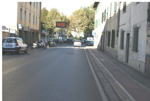
Foto 1 – vista Via Villamagna e ciclabile monodirezionale su marciapiede
