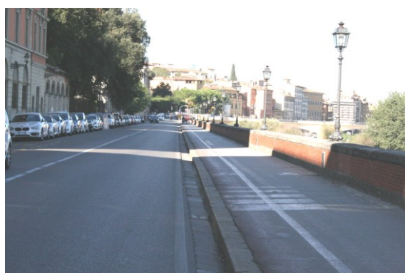
Foto 6 –Lungarno Serristori – ciclabile in dx e parcheggi da eliminare in sx
