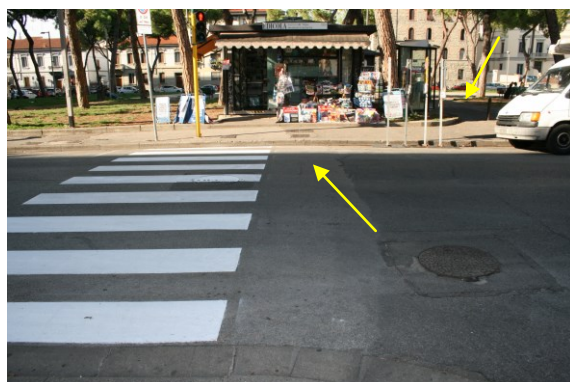
Foto 2 creazione di rampe e sbassamento marciapiede su Via Puccinotti
